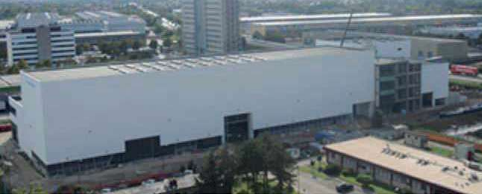
Figura 13 - Il complesso di edifici di PRIMA che ospiterà i due esperimenti SPIDER e MITICA
