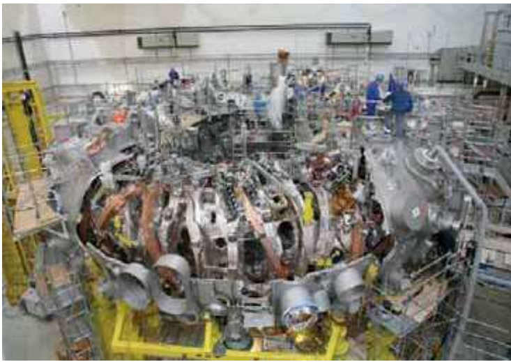
Figura 2 - Un esempio di confinamento magnetico, the Wendelstein 7-X, in costruzione
