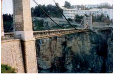
Il ponte di ARNODIN a Constantine (Algeria)
