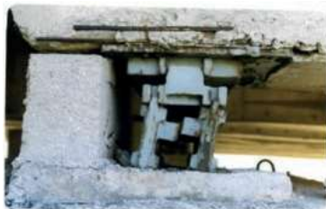
La perdita degli appoggi è particolarmente pericolosa in fase di sisma (Osaka 1995)
