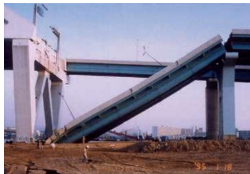
La perdita degli appoggi è particolarmente pericolosa in fase di sisma (Osaka 1995)
