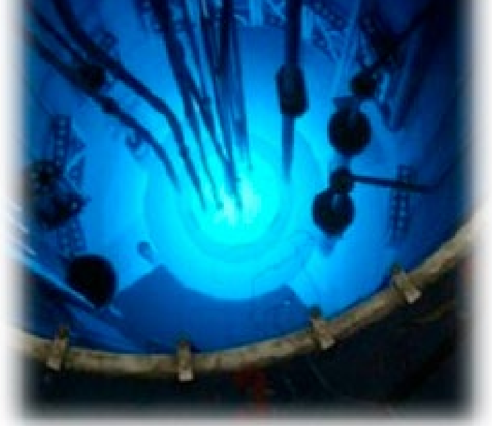
Figura 1: Visuale dal top del reattore del nocciolo con la caratteristica radiazione Cerenkov
