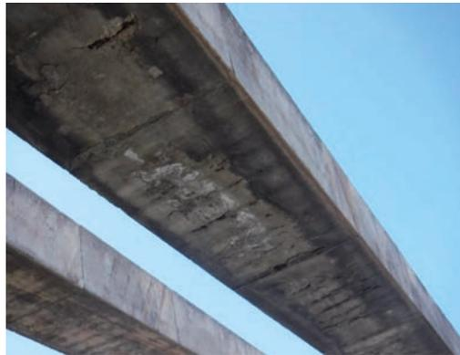
Figura 5 – Degradamento superficiale degli stralli
