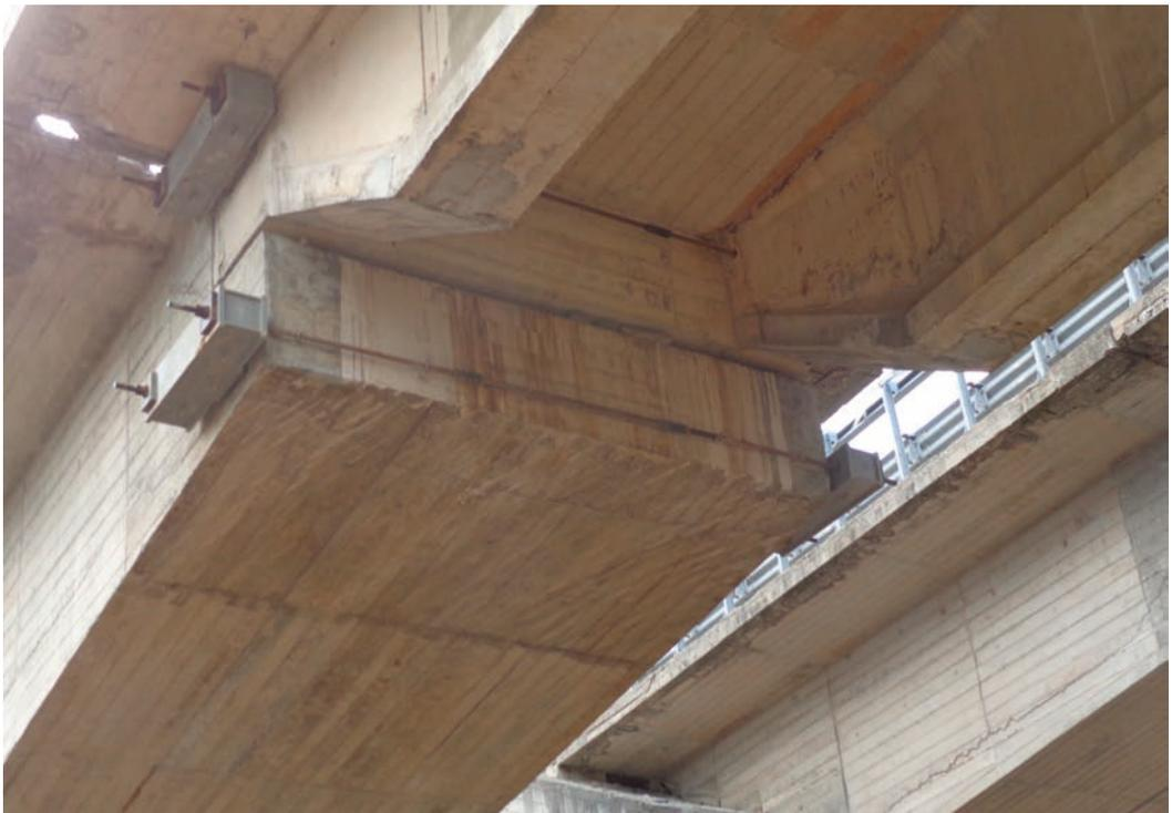
*Figura 21 - Precompressione dei traversi in opera*
