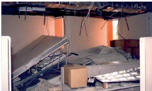
Figura 2 - vista interna con danni agli elementi non strutturali
