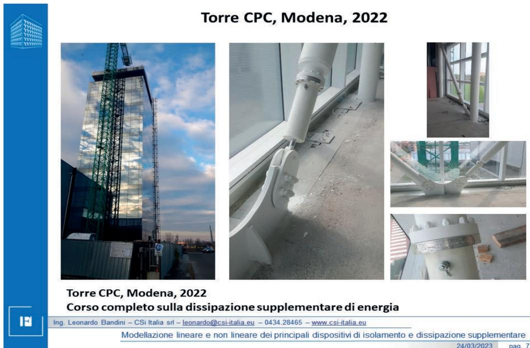
Figura 15 - vista dei dispositivi di dissipazione supplementare integrati nei controventi
