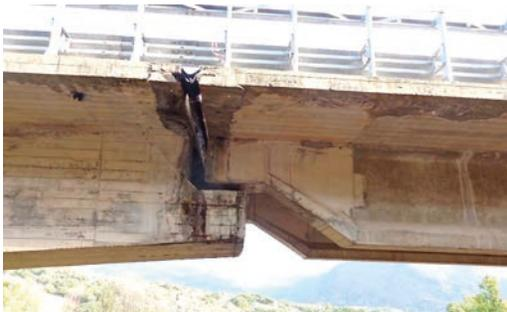
Figura 4 – Degradamento superficiale della sella Gerber
