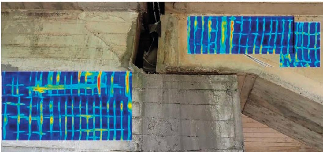
Figura 8 - Rilievo armature e cavi selle Gerber
