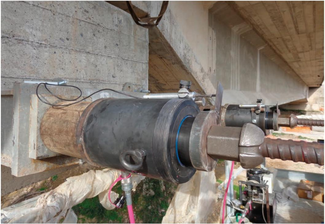
*Figura 20 - Fase di precompressione dei traversi in opera*
