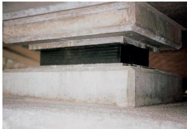
Figura 3 - Appoggi elastomerici
