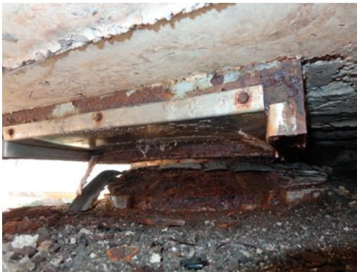
Figura 6 – Degradamento degli apparecchi di appoggio
