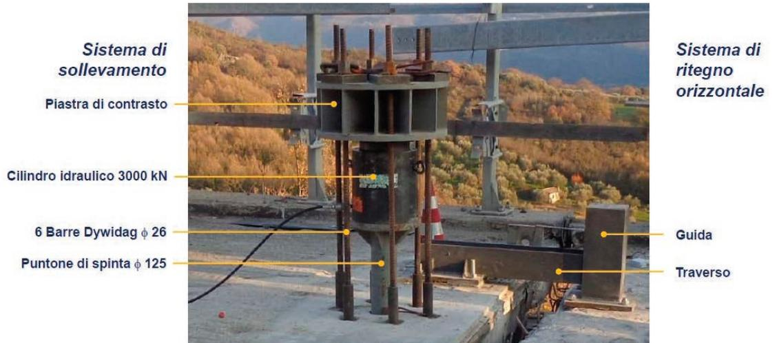
Figura 25 - Dettaglio sistema di sollevamento
