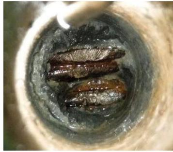
Figura 9 - Ispezione endoscopica dei cavi di precompressione
