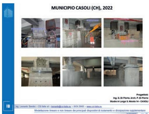
Figura 20 - isolamento sismico struttura esistente
