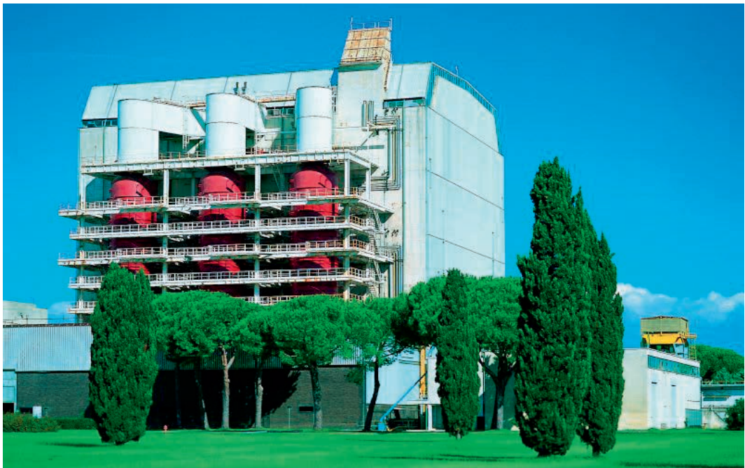
Figura 1 Centrale di Latina, vista esterna
