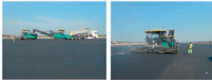
Stesa del conglomerato bituminoso con utilizzo di finitrice a banco largo e nastro caricatore intermedio
