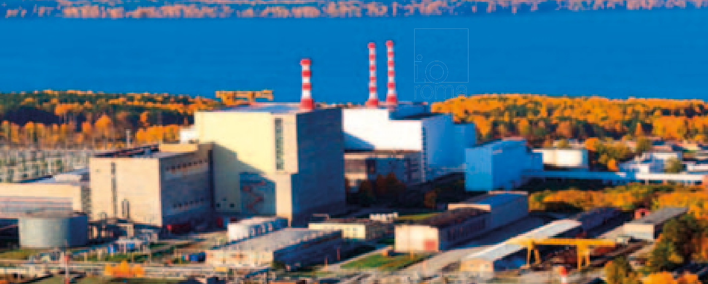
Figura 20 - Veduta del sito nucleare di Belojarsk, nei pressi di Ekaterinburg (Federazione Russa), dove sono installati gli unici 2 reattori a neutroni veloci, refrigerati a sodio, attualmente in esercizio commerciale, il BN 600 (Belojarsk-3, 1981) e BN 800 (Belojarsk-4, 2015), che convenzionalmente appartengono alla cosiddetta Gen. IV.
