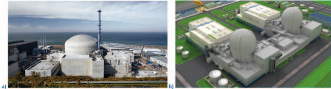
Figura 22 - a) EPR presso la centrale nucleare di Flamanville (Francia) - Photo courtesy EDF Médiathèque. b) Rendering di una centrale nucleare con 2 unità APR-1400 (Fonte: KHNP)
