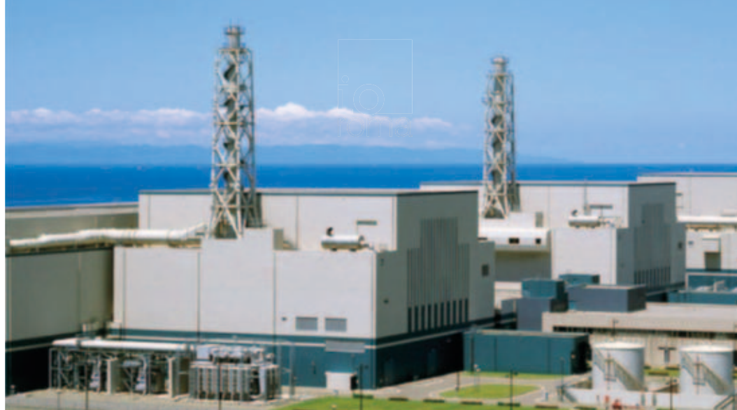
Figura 25 - Veduta delle due unità ABWR della centrale di Kashiwazaki-Kariwa, unità 6 e 7 in servizio dal 1996, Giappone, Fonte: Tokyo Electric Power Company Holdings, Inc.
