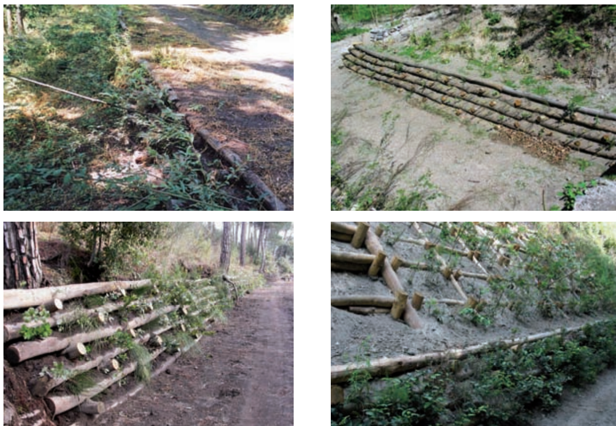
Figura 10: Sistemazioni di versante e idraulica tra antichi ruderi a Monte Somma (da G. Menegazzi, 2002)
