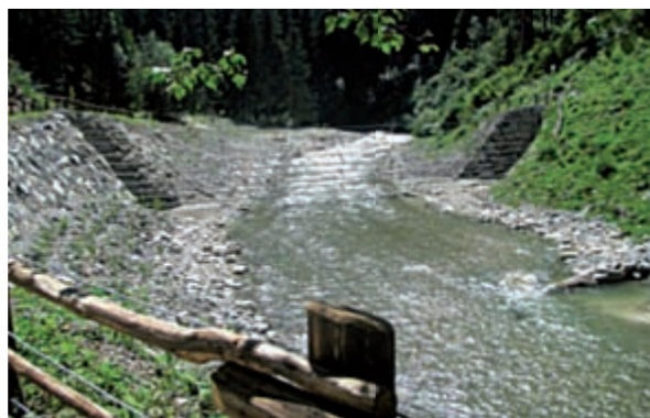
Figura 3: Briglia di fune per tronchi flottanti e sistemazione spondale su fiume Rienza in Val Pusteria (da F. Boccalaro, 2013).
