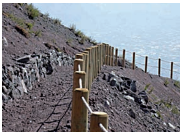
Figura 8: Sentiero attrezzato in quota e muretto a secco (da G. Menegazzi, 2001)
