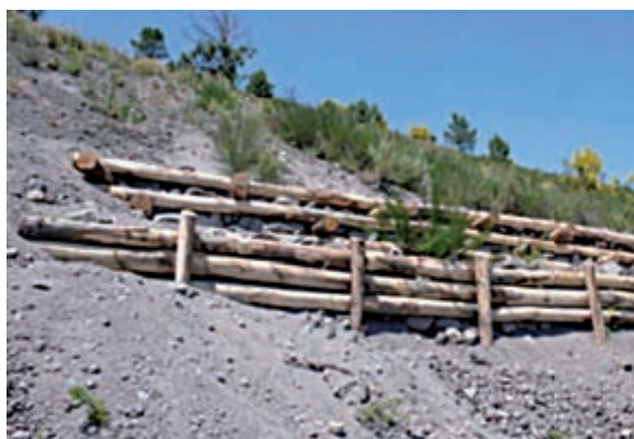
Figura 9: Palificata e palizzata vive in legname e pietrame (da G. Menegazzi, 2001)
