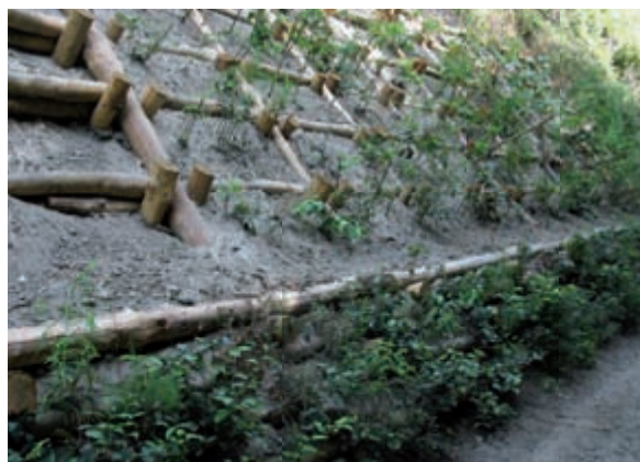
Figura 10: Sistemazioni di versante e idraulica tra antichi ruderi a Monte Somma (da G. Menegazzi, 2002)
