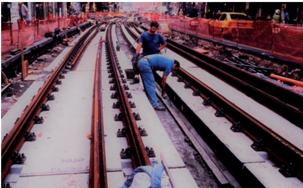
Figura 6 - Via Arenula, costruzione dell'armamento su platee prefabbricate, giugno 1997.
