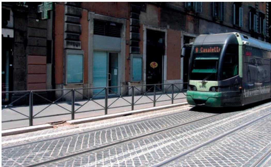
*Figura 7 - Pavimentazione in falsi sampietrini della sede tranviaria di Via Arenula.*
