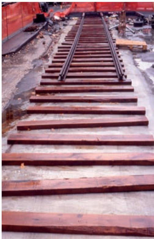
*Figura 8 - Realizzazione dell'armamento di Ponte Garibaldi, con rotaie da ponte e traverse di altezza ridotta, settembre 1996.*
