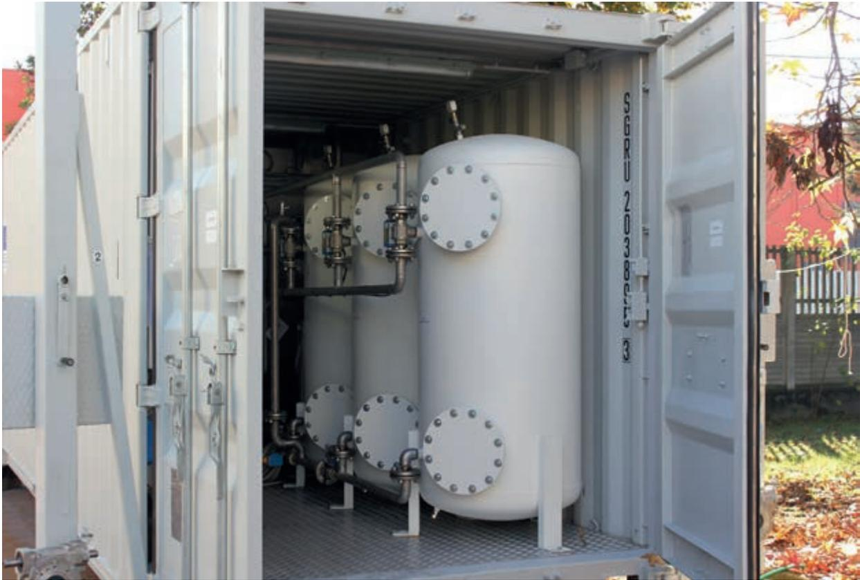
Figura 3 - Vista interna di un impianto di potabilizzazione trasportabile.
